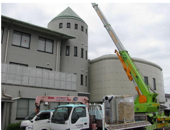
屋上の室外機の入替え
