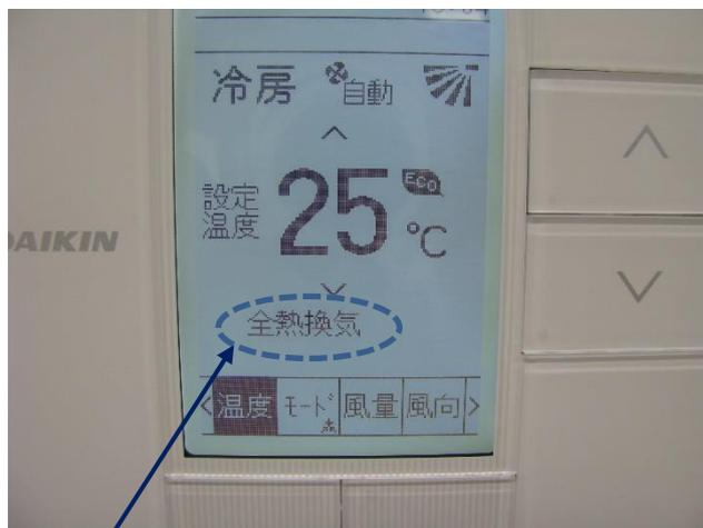
全熱換気:冷暖房と同時に換気
